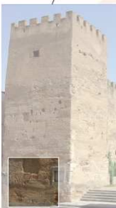
Sillares de la torre de la Yérba
