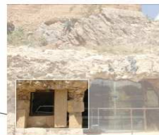
Sillares de la torre coracha
